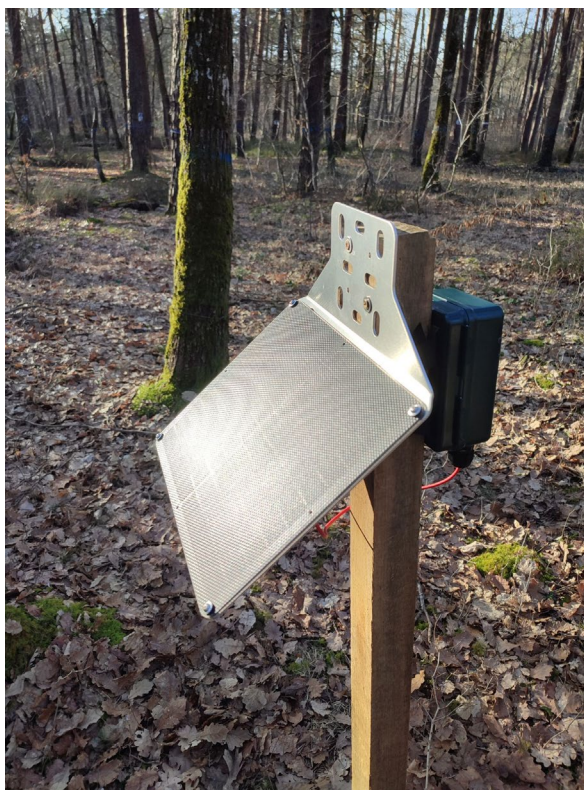
Système d'alimentation solaire pour enregistreurs sur placettes niveau 3
